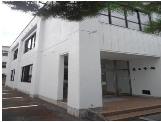
鷹工会館 外装工事
